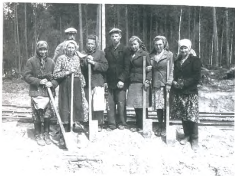
Бригада на ремонте УЖД
