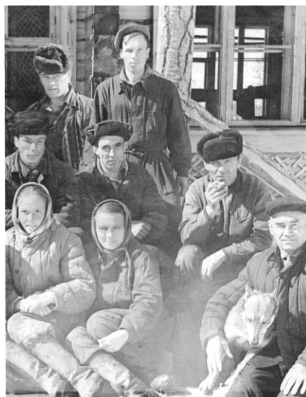
1961 год май. Бригада Ядрышникова Авакума Семёновича на строительстве школы по улице Ленина.
