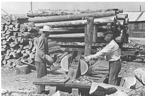
1962 г. Рабочие Луговского лесопункта на расколке дров электроколуном для нужд паровой электростанции и паровозов УЖД. Слева Мазуров Фёдор Васильевич.
