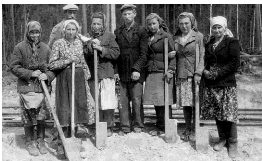
1960-е г. Бригада по ремонту узкоколейной железной дороги Луговского лесопункта. В центре бригадир Сафошкина Валенина Васильевна.
