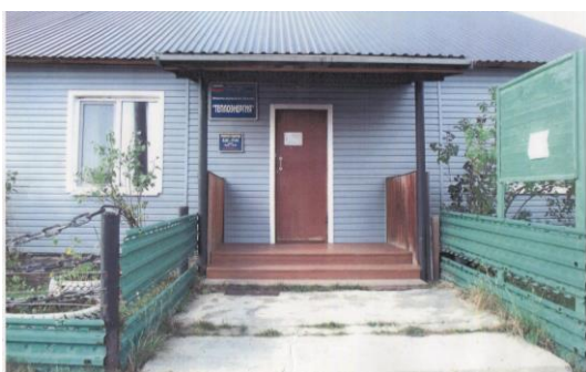
2010 г. Контора ОАО «Теплоэнергия».
