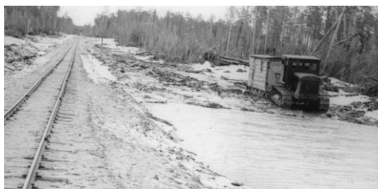
Весна 1962 год. Перебазировка бригады верхнего склада Луговского лесопункта с зимних лесосек на летние. Трактор С-80 перевозит обогревательный балок.
