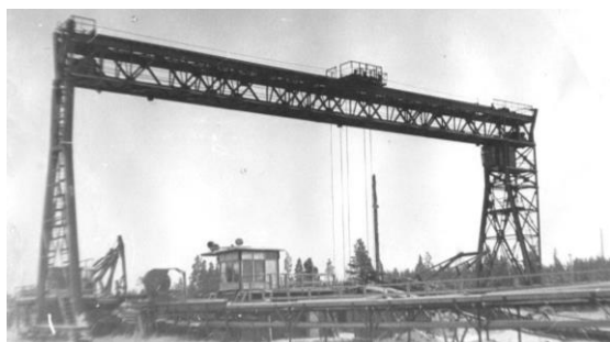
1980-е г. Нижний склад Луговского леспромхоза.
