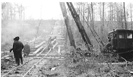
1963 год. Строительство УЖД основной магистрали бригадой Луговского лесопункта.
