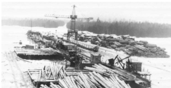
1980-е г. Нижний склад Луговского леспромхоза.
