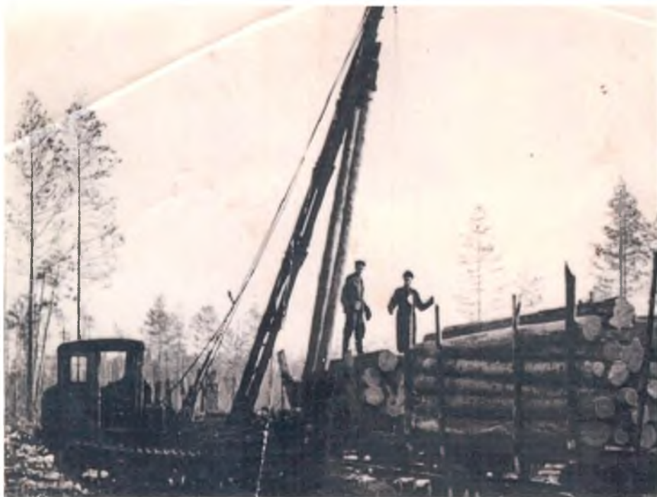
1963 год. Погрузка леса тракторокраном на подвижной состав УЖД. Бригада Самохвалова Фёдора Прокопьевича
